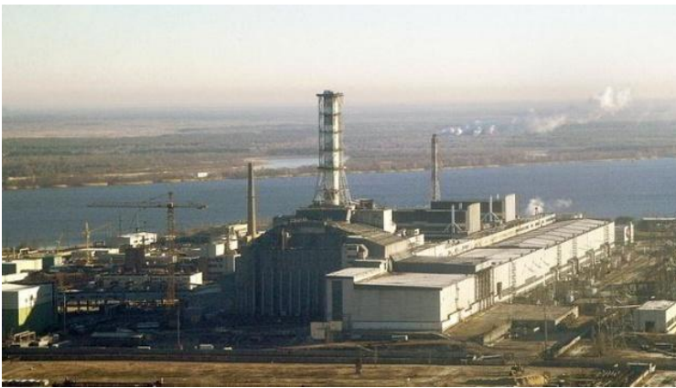
Чорнобильська атомна електростанція
